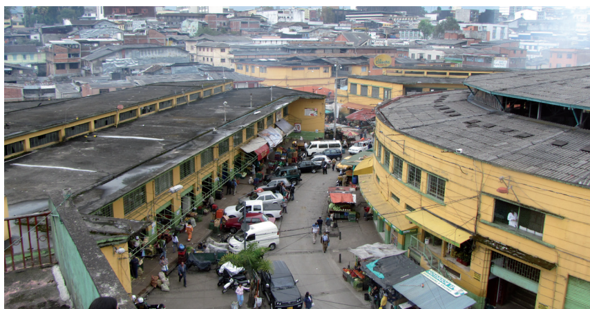
Fotografía No.1 Panorámica parcial de la Galería. Fotografía: Fernando Cantor Amador
