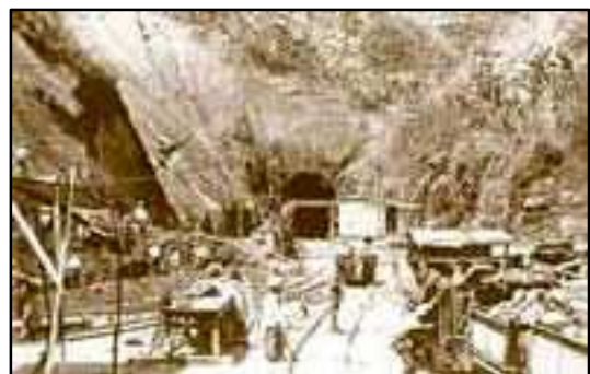
Figura 2. El túnel de la Quebra (1876) Ferrocarril de Antioquia
