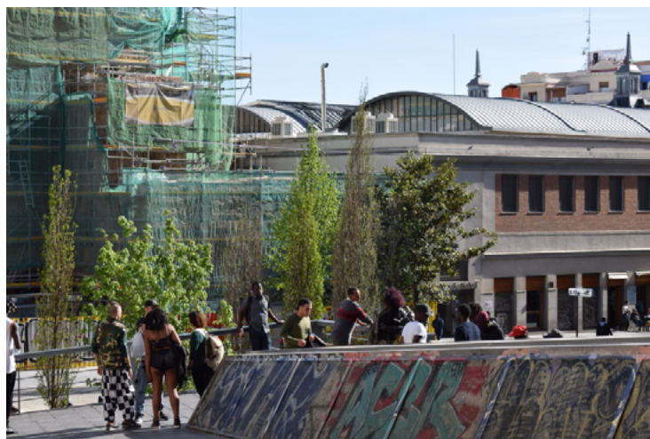
Figura 4. Plaza Arturo Barea y edificio de las Escuelas Pías en rehabilitación
